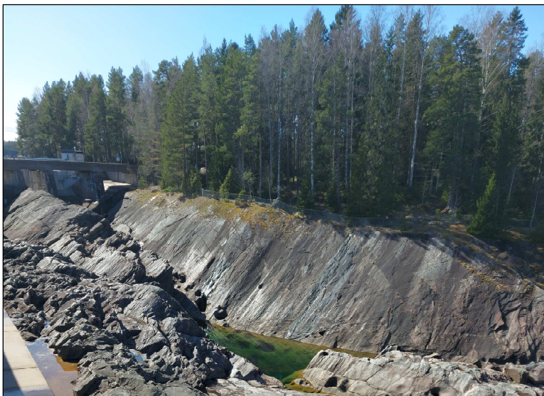
Torråra i Dalälven vid Älvkarleby kraftverk (foto: SGS Analytics Sweden AB).
