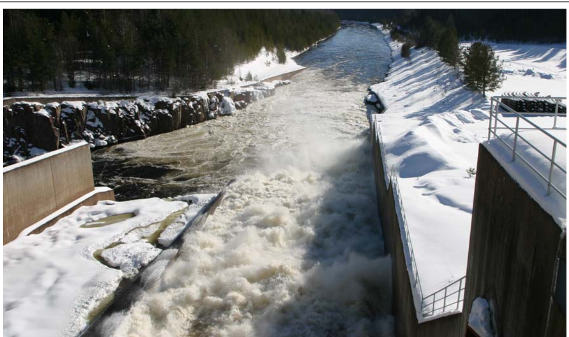
Figur 1. Kraftverket vid Mora Spjutmo.
